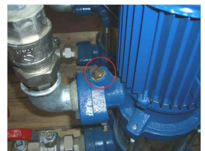
Rys. 8: montaż przetwornika do otwór wentylacyjny na pompie tłoczącej
