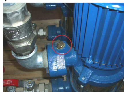
Rysunek 7: Montaż przetwornika w otworze wentylacyjnym 1/4"
